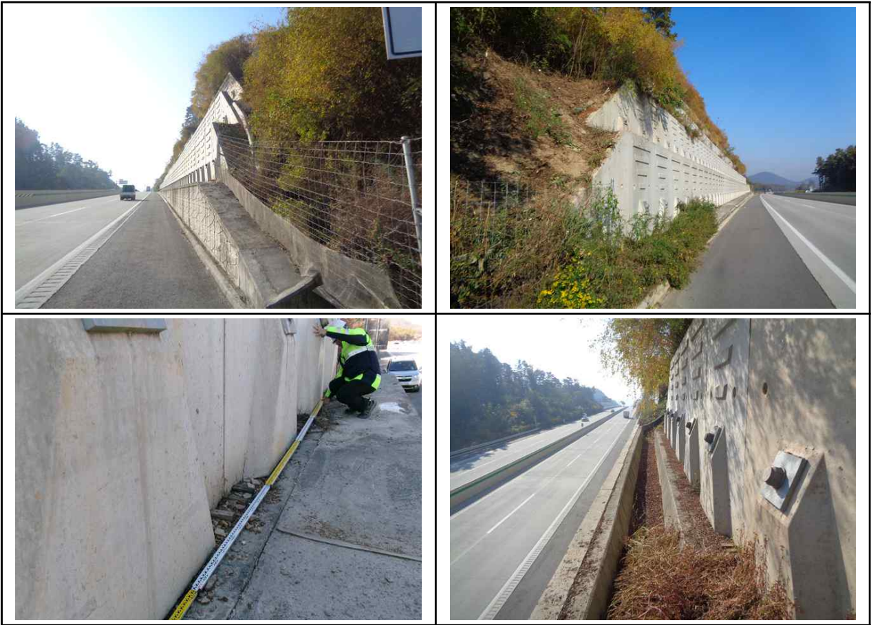
【그림 7.9】 외관조사 전경
