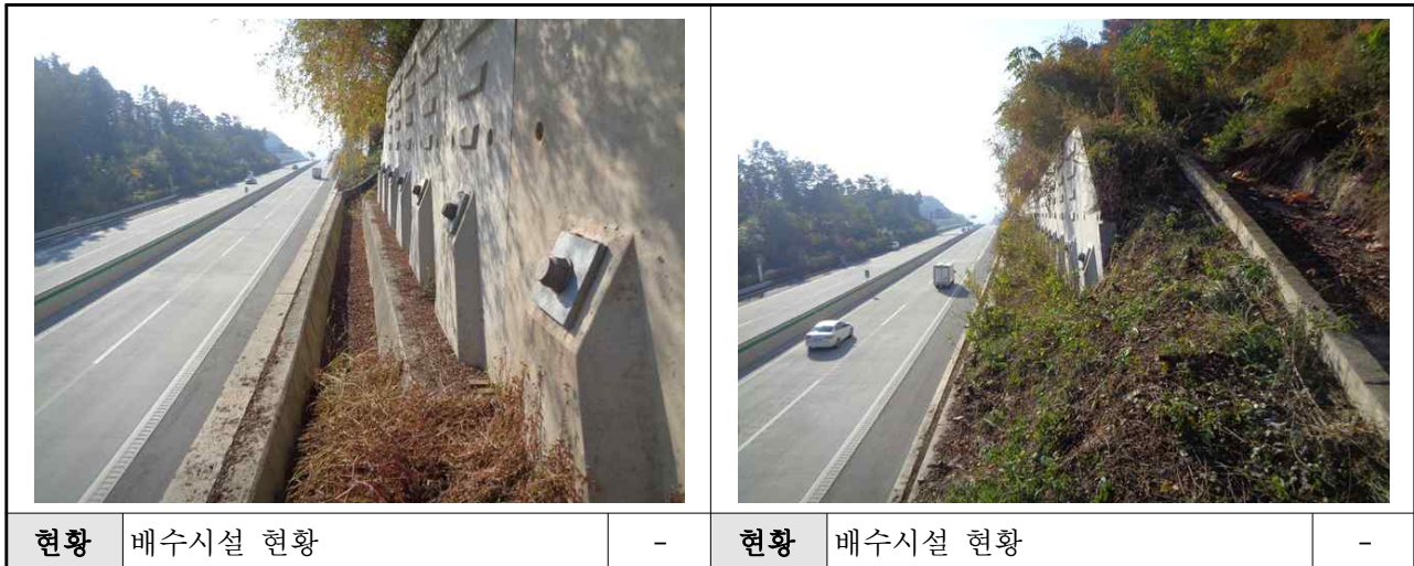
【사진 7.6】 옹벽 배수시설 현황
